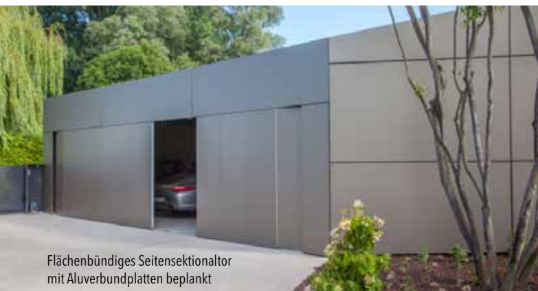
Privathaus Aachen, flächenbündige Rahmen-Sprossen-Konstruktion mit Cortenstahl-Beplankung
