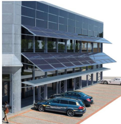
Mit Hebefaltläden, die mit Photovoltaik belegt sind, kann die Fassade als Kraftwerk genutzt werden.
