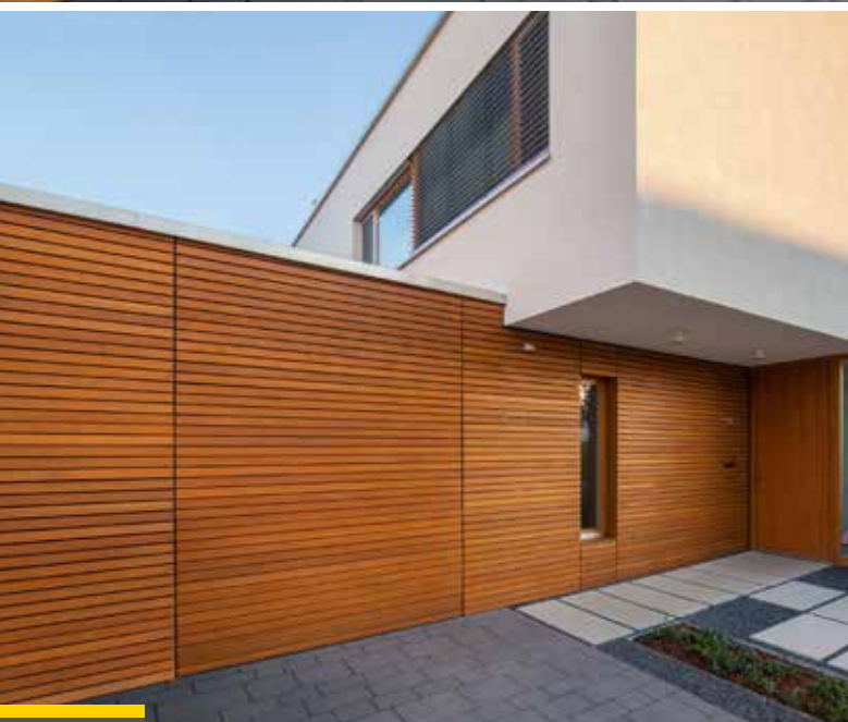
Homogene Fassade in geschlossenem Zustand
