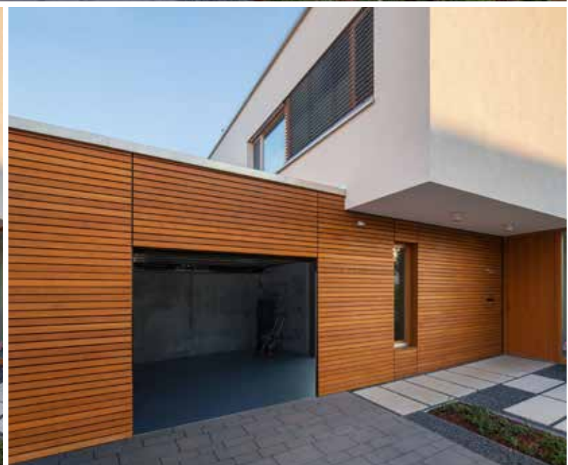
Unsichtbare Holzverkleidung ohne sichtbare Verschraubung der einzelnen Lamellen
