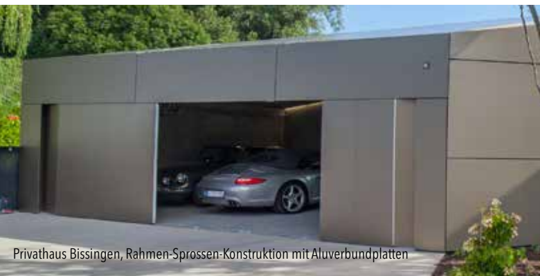
Aluminium-Rahmen-Sprossen-Konstruktion, Beplankung bauseits
